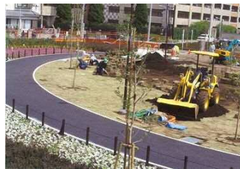
工事中の鮫洲入江広場 (平成25年)
