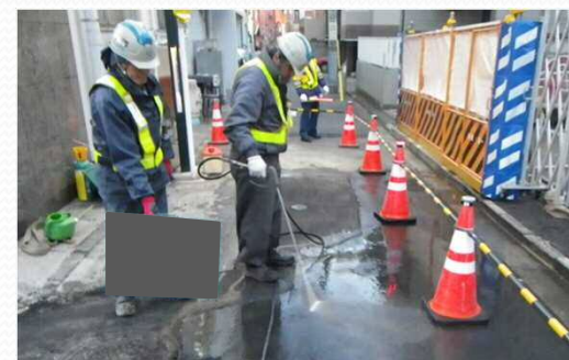
路面高圧洗浄 例
