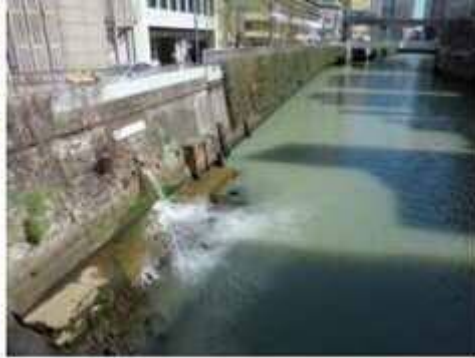
地下鉄地下水排出口
