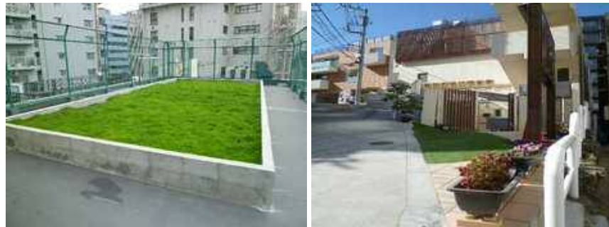
（左）大崎ひまわり保育園屋上緑化 セダムが植えられています
