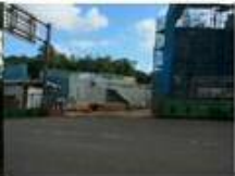
建設中の浄水場（標高 50m）
