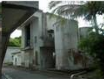
稼働中の浄水場（厩浦）
