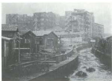
日本光学工業大井工場 手前を立会川が流れる(昭和20年頃)
