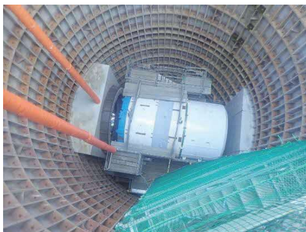
雨水排水施設工事
