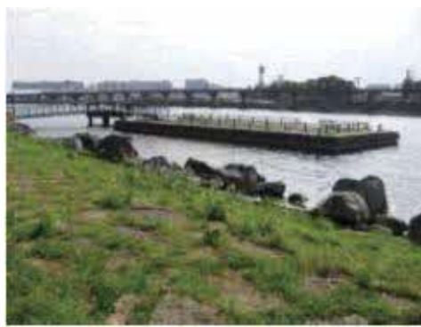
東京都により震災時水上輸送基地に指定されている船着場 (大井ふ頭中央海浜公園)
