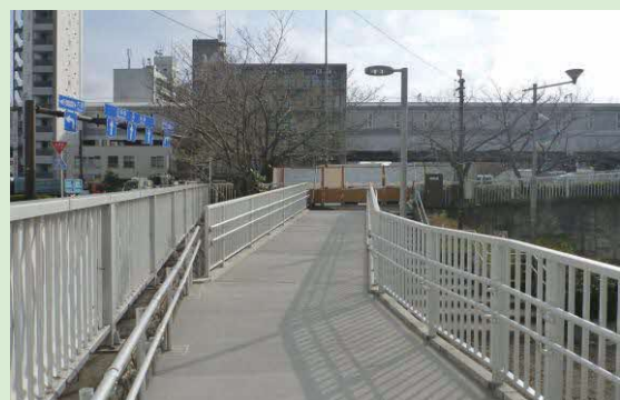
スロープの設置（東海橋船着場）
