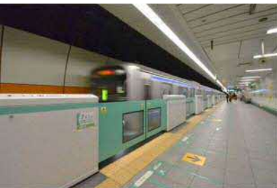
可動式ホーム柵の設置
