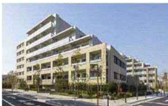
中延二丁目旧同潤会地区防災街区整備事業
