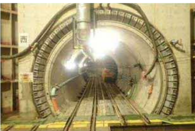
浸水被害を軽減する下水道管整備
