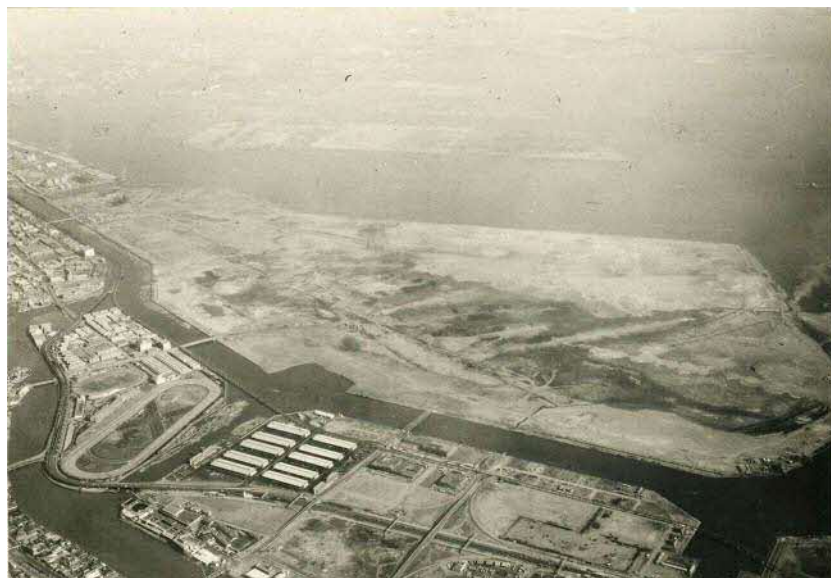
埋立中の大井ふ頭(昭和45年) (写真提供)東京都港湾振興協会
