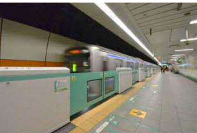
可動式ホーム柵の設置
