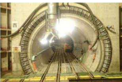
浸水被害を軽減する下水道管整備
