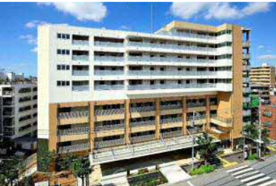
西中延区営住宅
