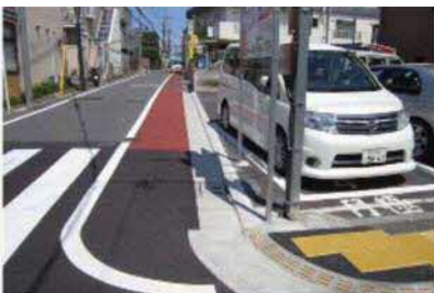
防災生活道路の拡幅整備
