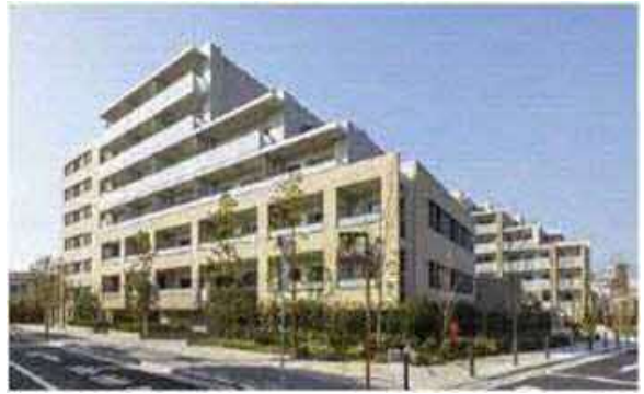
中延二丁目旧同潤会地区防災街区整備事業
