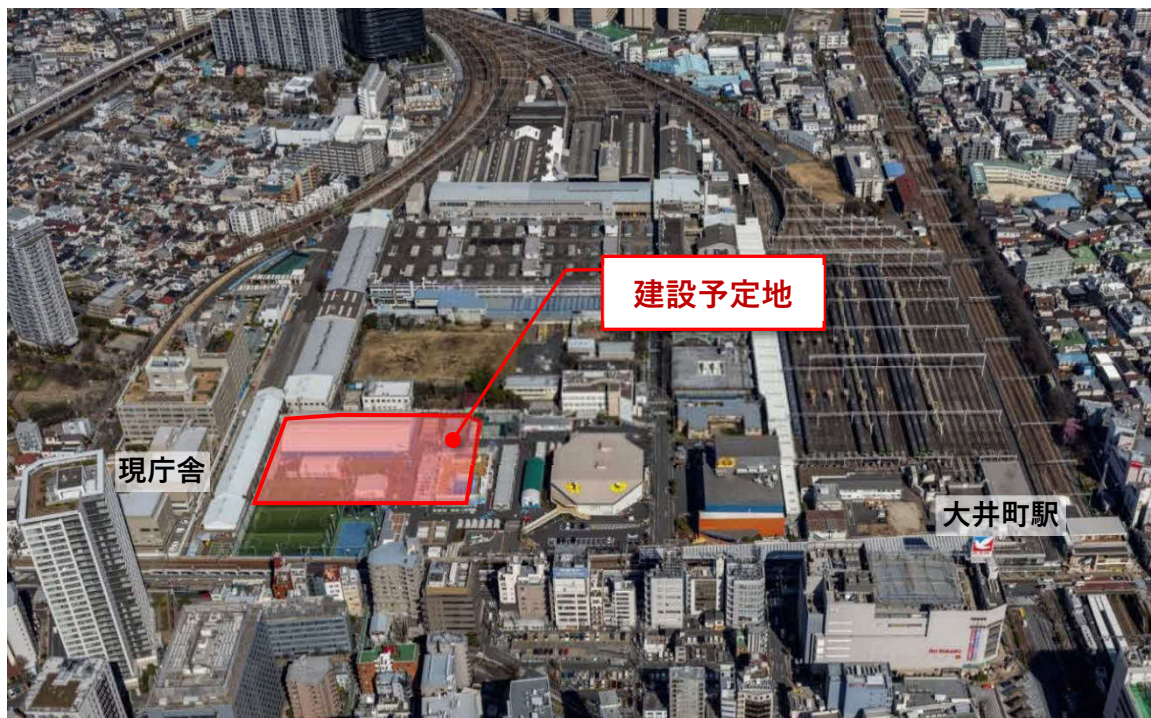
図表 3-2 建設予定地の現況
