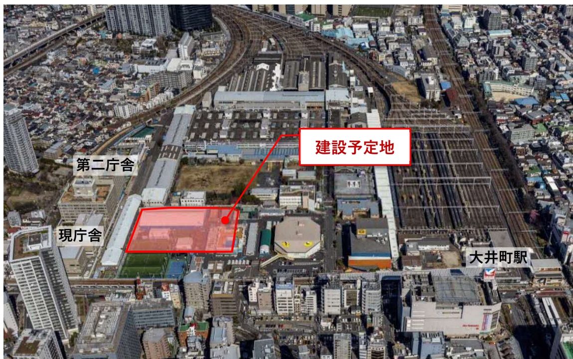
図表 3-2 建設予定地の現況
