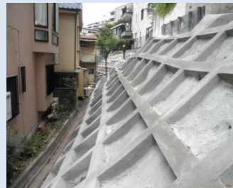
C：補強工事
