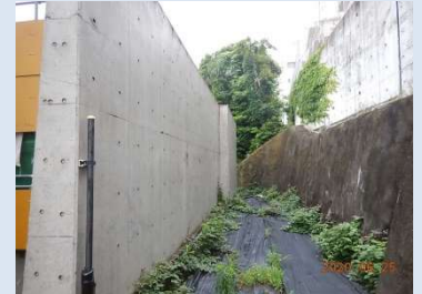
D：防護壁の設置
