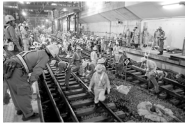
2,200人を動員して地下化の切り替え工事を行った (7/2)
