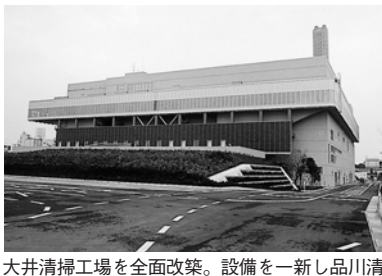
大井清掃工場を全面改築。設備を一新し品川清掃工場と名称変更して操業開始 (3/28)
