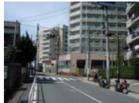
【駅前の住居棟の建設】
