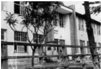
完成したばかりの荏原支所/昭和26年
