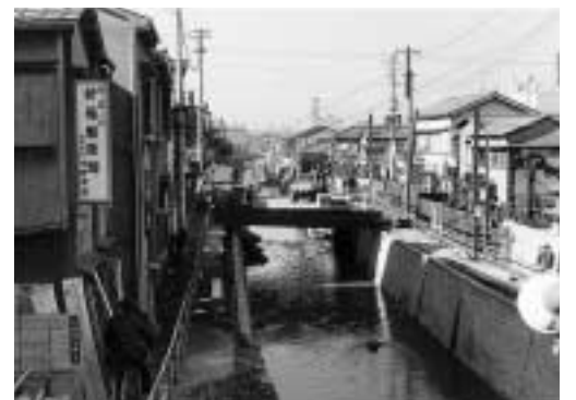
ふたかけ工事の始まった立会川（中延5～6丁目あたり）／昭和45年
