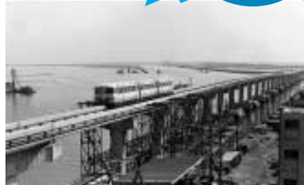
建設中の大井競馬場前駅とモノレール / 昭和40年
