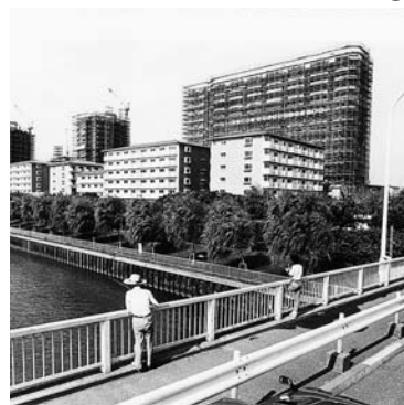
建設中の八潮パークタウン／昭和57年
