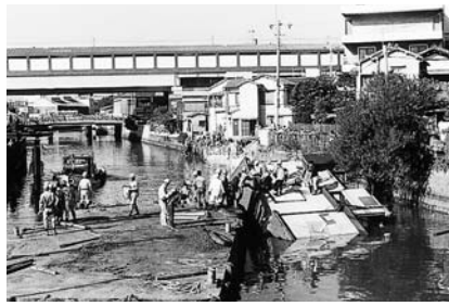
写真⑦ 目黒川護岸が決壊し、流された民家（北品川2丁目）／昭和56年
