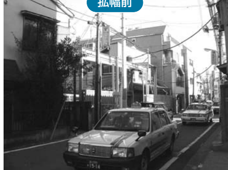
百反通りを拡幅。日常の交通や災害時の避難路を確保するため、道幅を約6.5mから11mに広げた
