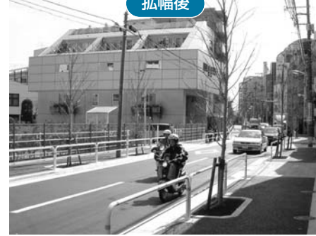
百反通りを拡幅。日常の交通や災害時の避難路を確保するため、道幅を約6.5mから11mに広げた
