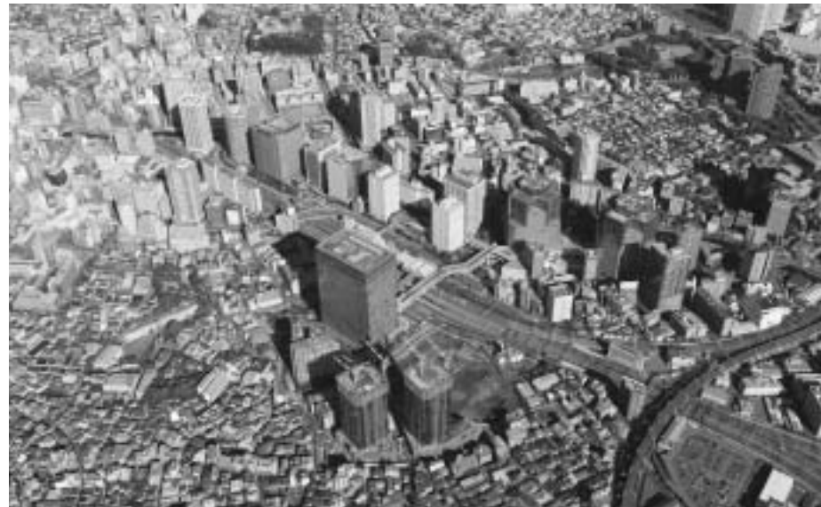
大崎駅周辺地区整備
