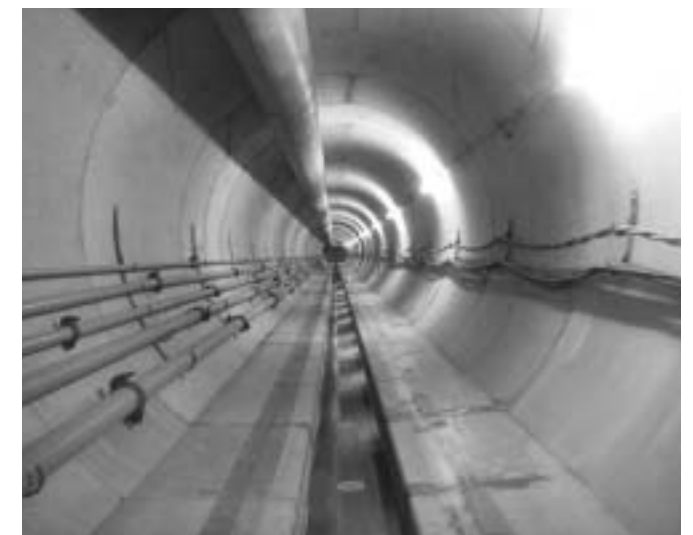
雨水排水管(シールドトンネル)
