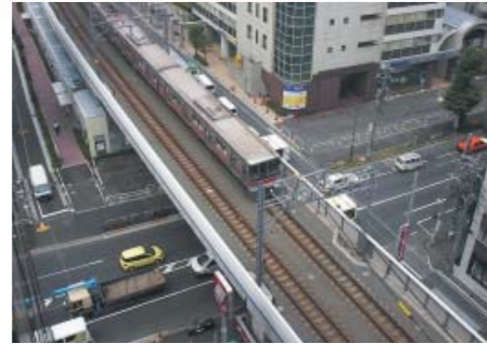
東急目黒線連続立体交差事業
