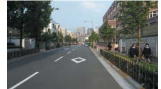
補助第205号線 歩車分離により交通の安全性が向上 (西大井1丁目光学通り)
