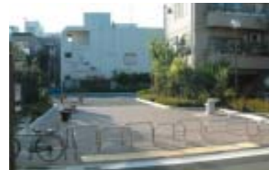
防災広場の整備 (弁天通り公園 中延5丁目)
