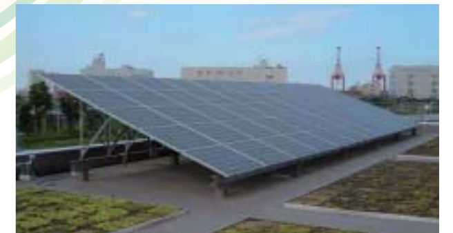
太陽光パネル (品川区資源化センター 八潮1丁目)
