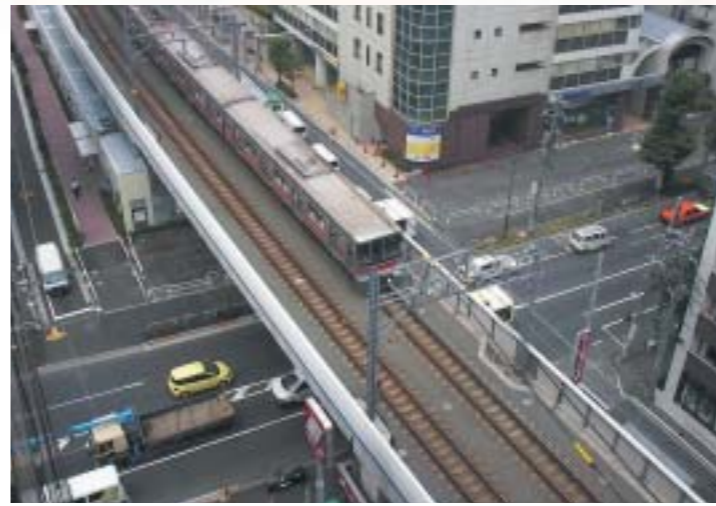
東急目黒線連続立体交差事業
