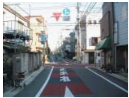
交差点改良 (交差点の色付け・停止線前のすべり止め舗装 戸越5丁目)
