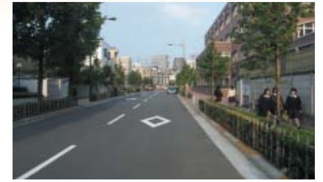
補助第205号線 歩車分離により交通の安全性が向上 (西大井1丁目光学通り)
