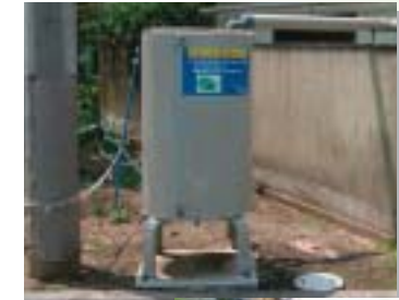
雨水利用タンク (立会川脇)
