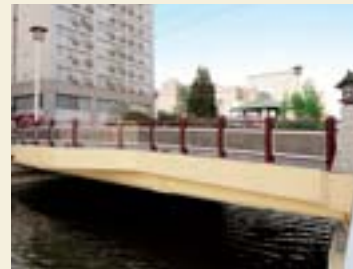
B 品川橋 かつては境橋と呼ばれた。品川橋の位置は昔と変わっていない
