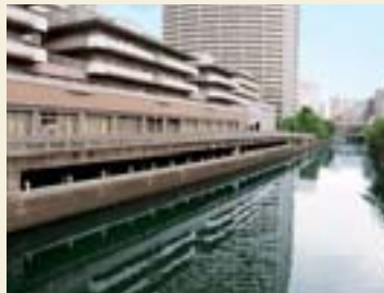
E 荏原調節池（流入部） 目黒川の増水時、地下4層構造の貯留池に水が流れ込む仕組み
