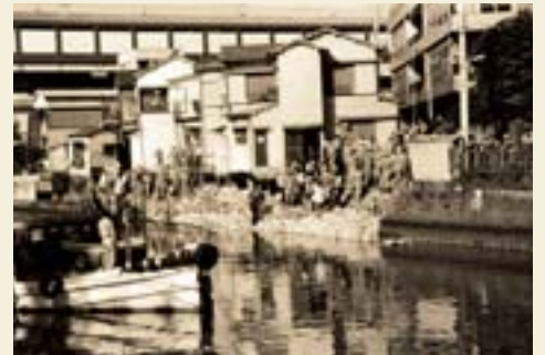
2 昭和 56 年 10 月、前夜からの大雨で目黒川の護岸が崩れ、民家が流されるなどの被害があった（北品川 2）
