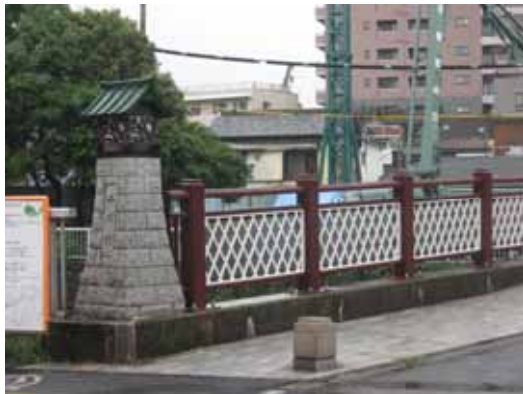
目黒川に架かる品川橋の修景
