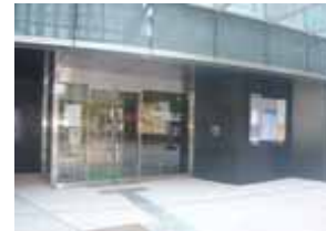
大崎第二地域センター <正面玄関>
