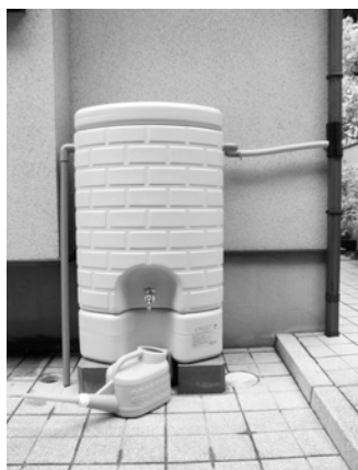
雨水利用タンク
