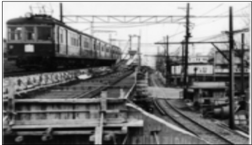
1964年2月 大井町線と中原街道との立体交差工事
