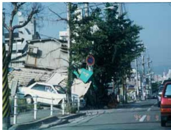
阪神大震災において街路樹が倒壊建物から道路を守った例 (神戸市提供)
