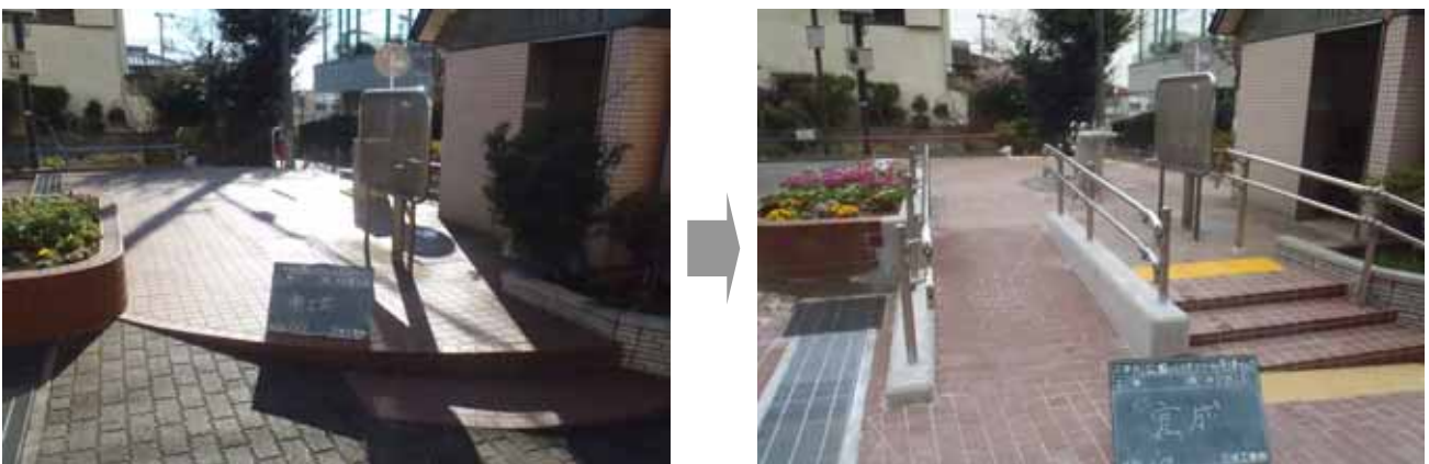
公園のバリアフリー化の例（スロープ、手すり、点字ブロック等の設置、戸越台公園）
