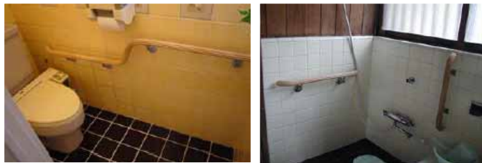
バリアフリー施工工事事例(東京都住宅バリアフリー推進協議会)
