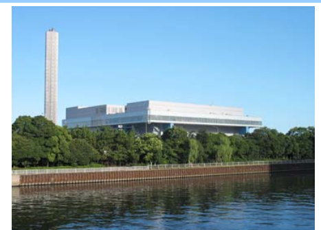
平成18年に竣工した品川清掃工場
