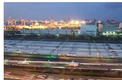
集積が進んだ車両基地
