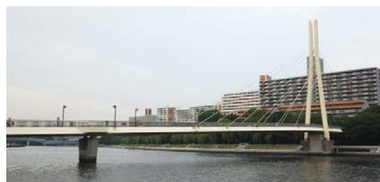
勝島と八潮を結ぶ人道橋のかもめ橋
