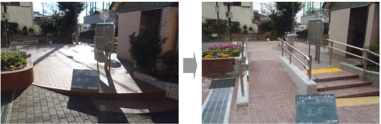
公園のバリアフリー化の例（スロープ、手すり、点字ブロック等の設置、戸越台公園）
