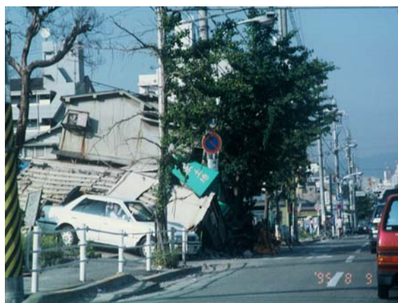
阪神大震災において街路樹が建物倒壊による道路閉塞を防いだ例 (写真提供：神戸市)
