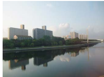
地域冷暖房が導入された八潮団地
