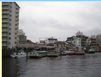
舟宿や屋形船が並び、観光資源としても期待される品川浦 内部護岸が未整備の箇所が残っている
