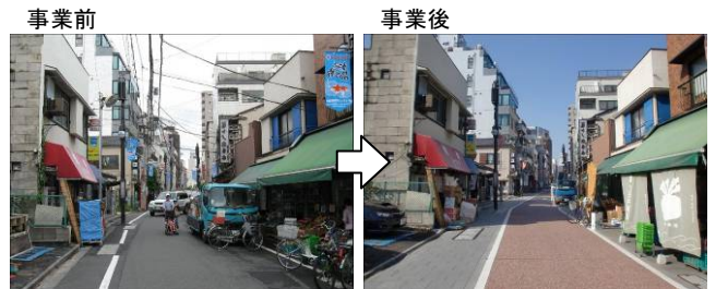
北品川地区の電線類の地中化、道路整備
