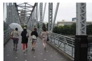
天王洲地区と品川駅東口地区 を結ぶ天王洲ふれあい橋
