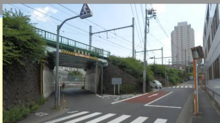
早急な整備が必要な補助163号線（西品川一丁目）
