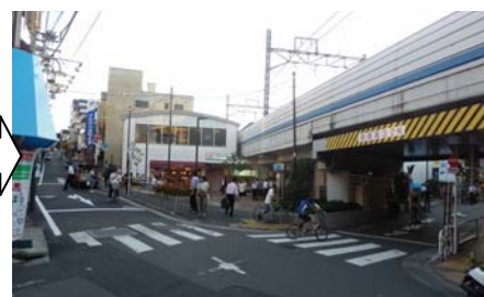
踏切が解消された不動前駅
