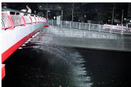
御成橋に設置された放水施設
