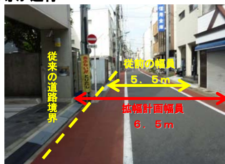
拡幅整備中の富士見通り
