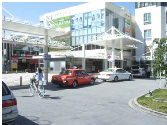
整備された西小山駅前広場
