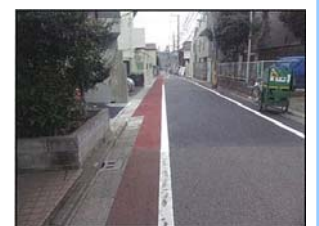
拡幅の進む大原通り
