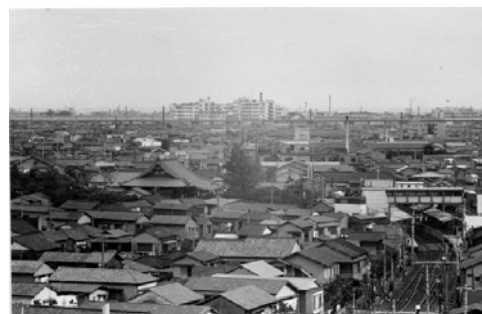
住宅等が密集する荏原町駅付近（昭和41年）
