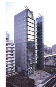
新南大井ビル (品川区南大井1丁目)
