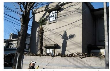
塀の上から顔を出すコンクリートの蔵
