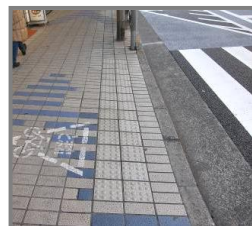
左から：連続して設置された点字ブロック、カラー舗装された路肩、歩道脇の鉢植えや駐輪、明度差が確保されていない点字ブロック
