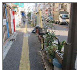
左から：連続して設置された点字ブロック、カラー舗装された路肩、歩道脇の鉢植えや駐輪、明度差が確保されていない点字ブロック
