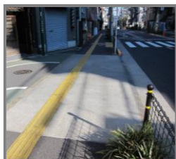
左から：連続して設置された点字ブロック、カラー舗装された路肩、歩道脇の鉢植えや駐輪、明度差が確保されていない点字ブロック
