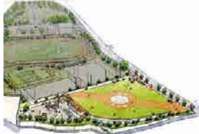
しながわ中央公園拡張整備
