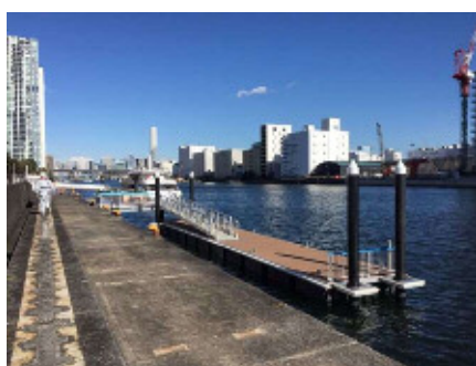
防災船着場 (東品川二丁目防災棧橋)
