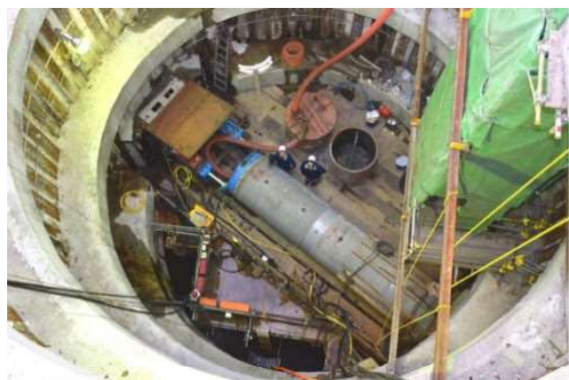
雨水排水施設工事
