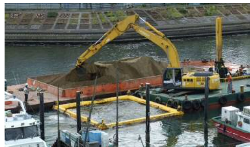
運河のヘドロと新しい砂の入れ替え
