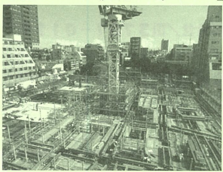
工事が進む現場の様子
