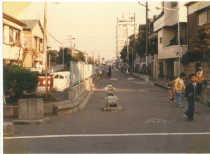
蓋架け後（昭和56年撮影） (的場橋から上流を望む)
