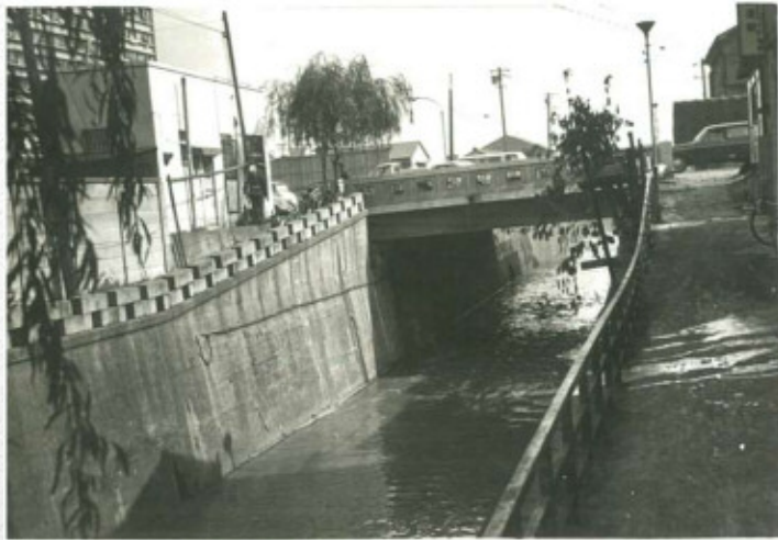
蓋架け前 (入道橋：第二京浜接続部)
