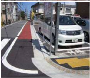
防災生活道路の拡幅整備
