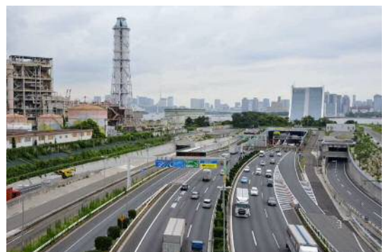
国道357号と首都高速湾岸線
