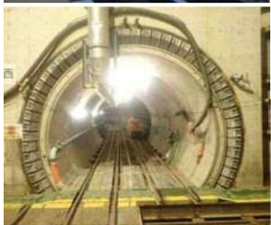
浸水被害を軽減する下水道管整備
