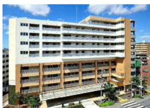
西中延区営住宅
