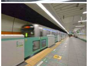
可動式ホーム柵の設置
