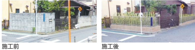
ブロック塀の除却とフェンス生け垣助成(30年度施工例)
