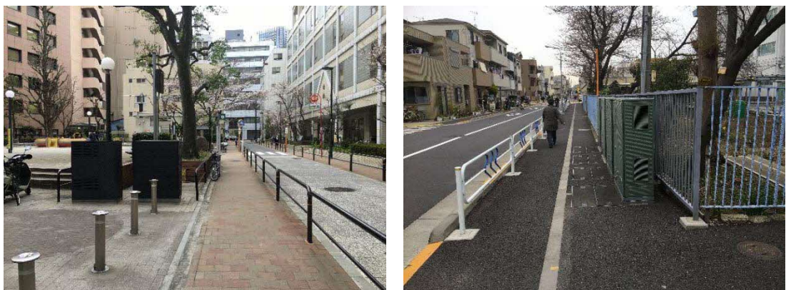
図21 学校や公園などの公共施設を活用して地上機器を設置した例
