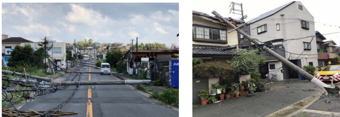
図6 台風21号により倒壊した大阪府内の電柱
