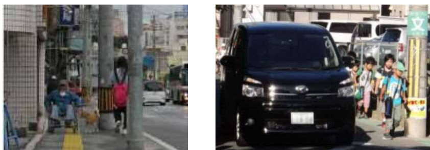
図8 歩行者の通行を妨げる電柱の例
