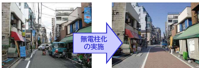
図7 旧東海道(北品川地区)における無電柱化の実施事例
