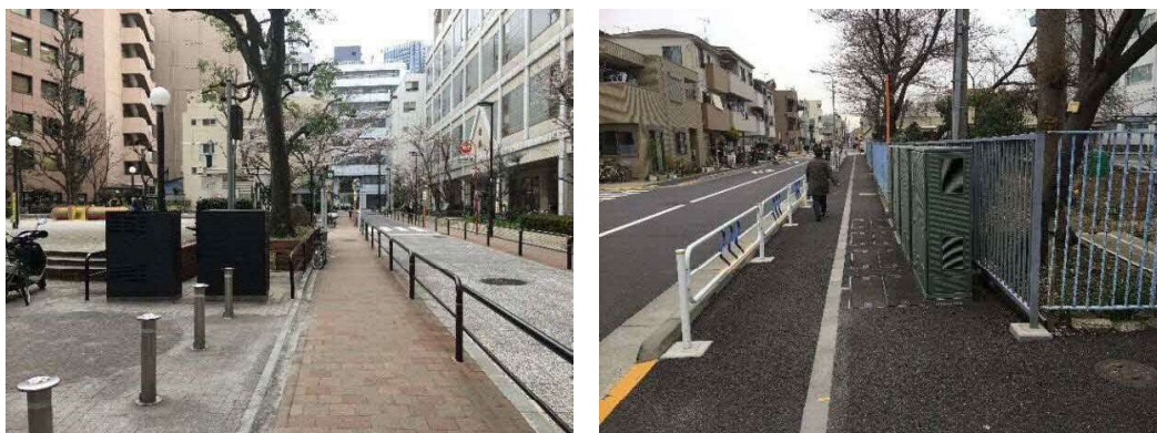
図21 学校や公園などの公共施設を活用して地上機器を設置した例
