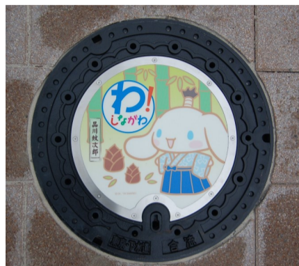
武蔵小山駅前に設置されたマンホール
