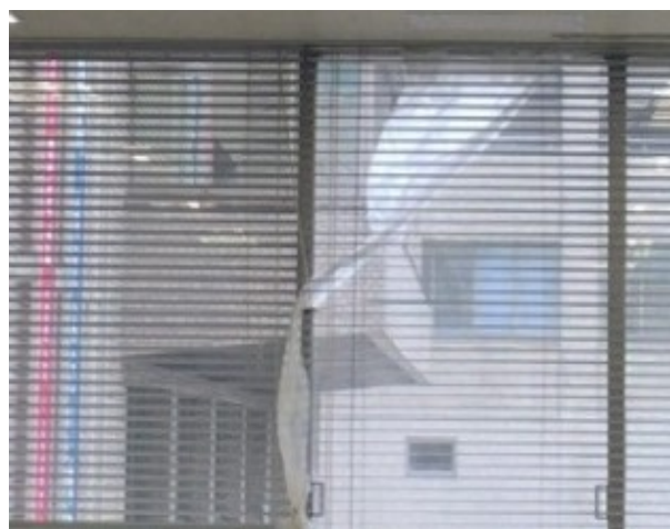
雨漏りをビニールで補強
